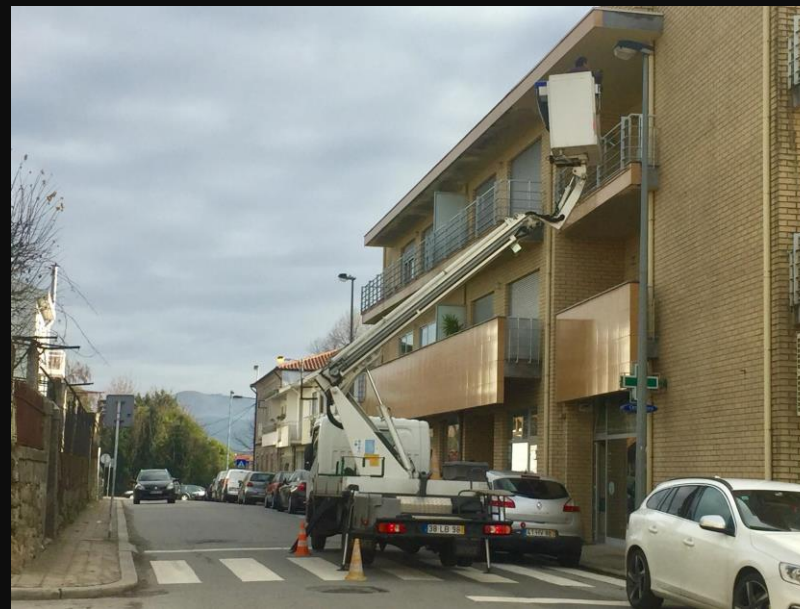
Fotografia - Substituição de luminárias
