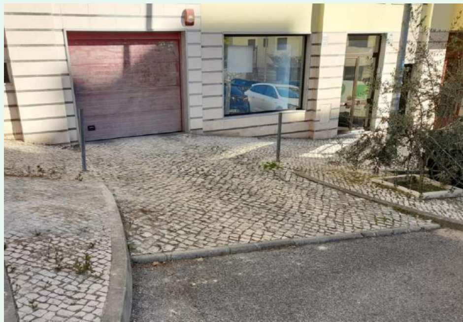
Requalificação de calçadas. Freguesia de Odivelas
